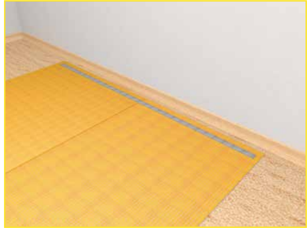
Abb.23: Erdungsband verkleben (nur bei 2 oder mehr Bahnen)
