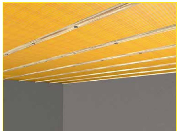
Abb.19: Fixe Befestigung der Bahnen - Entfernen der Hilfsnägel
