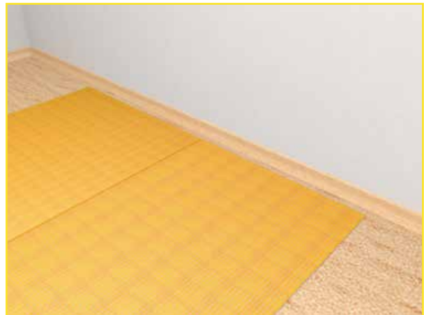
Abb.22: Schirmmaterial auslegen
