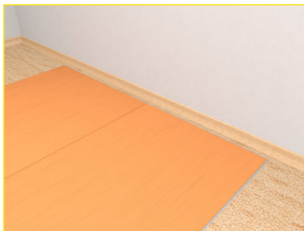
Abb. 22: Schirmmaterial auslegen
